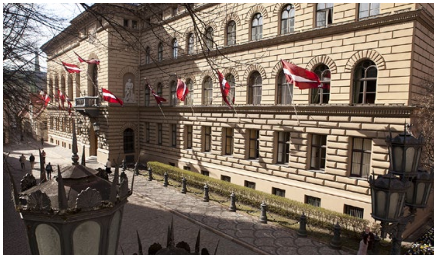
■ Saeimas nams Rīgā, Jēkaba ielā 11
